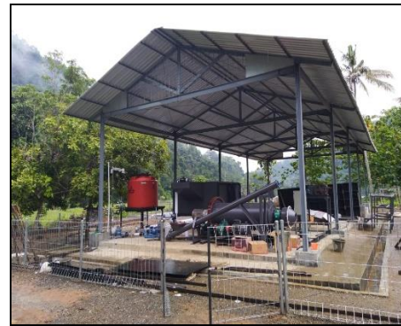
Gambar 1.13 Pembangunan Sarana Pengolahan Emas Non Merkuri Di Luwu
