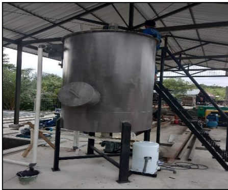
Gambar 1.12 Pembangunan Peralatan (Sarana) Pengolahan Emas Non Merkuri Di Kotawaringin Barat
