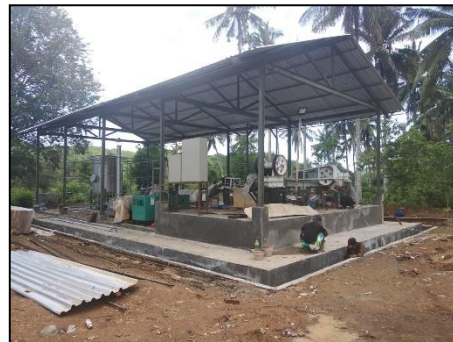
Gambar 1.15 Pembangunan Peralatan (Sarana) Pengolahan Emas Non Merkuri Di Lombok Barat
